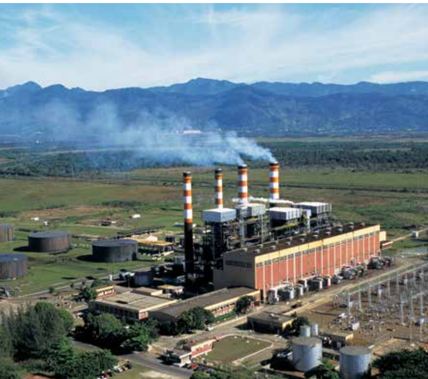
Usinas termelétricas, como a de Santa Cruz (RJ), usam gás natural ou derivados de petróleo para gerar energia quando o nível das hidrelétricas está baixo
